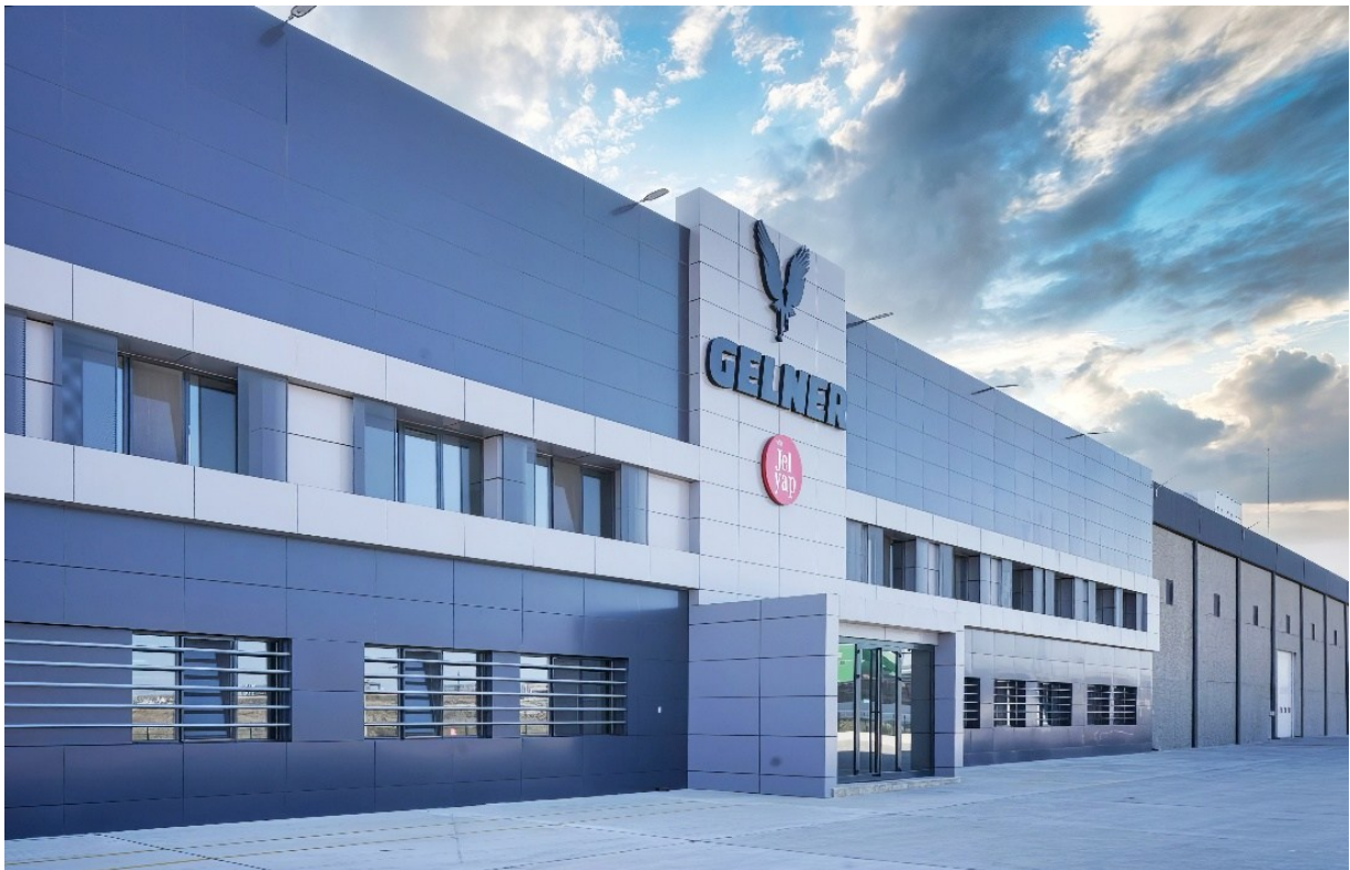
Fig. 3: Vista general de la planta de colágeno de Gelner Gıda en Gönen
