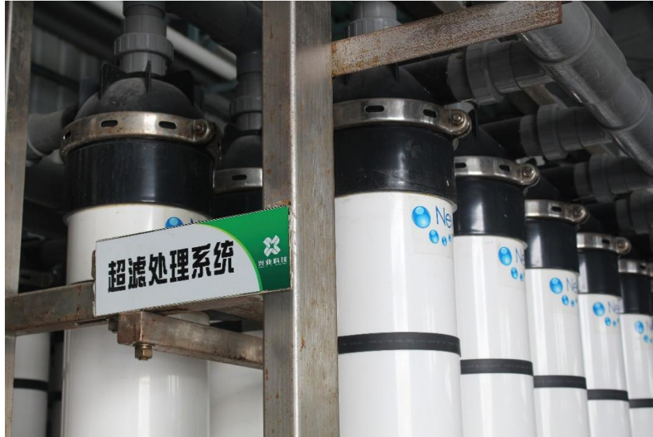
Şekil 4: Ultrafiltrasyon ekipmanının detayları
